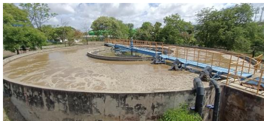
ระบบบำบัดน้ำเสียแห่งที่ 3 ชนิด Extended Activated Sludge
