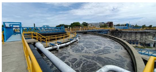
ระบบบำบัดน้ำเสียแห่งที่ 1 ชนิด Aerated Lagoon & Activated Sludge
