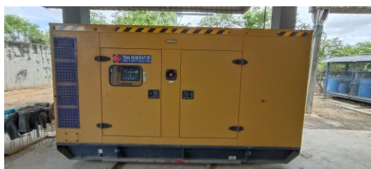
รูปที่ 9 ระบบไฟฟ้าสำรองของระบบบำบัดน้ำเสียส่วนกลางของนิคมฯ
