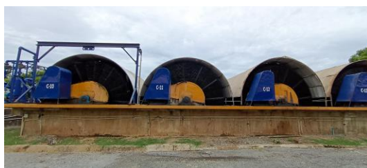
ระบบบำบัดน้ำเสียแห่งที่ 2 ชนิด Rotating Biological Contractor (RBC)
