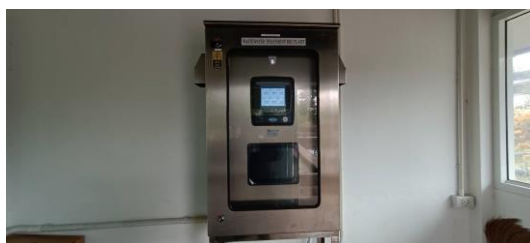
รูปที่ 10 เครื่องตรวจวัดคุณภาพน้ำอัตโนมัติ
