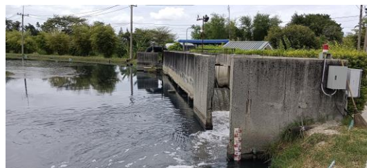
รูปที่ 4 ฝายหน้าบ่อ Aerated Lagoon
